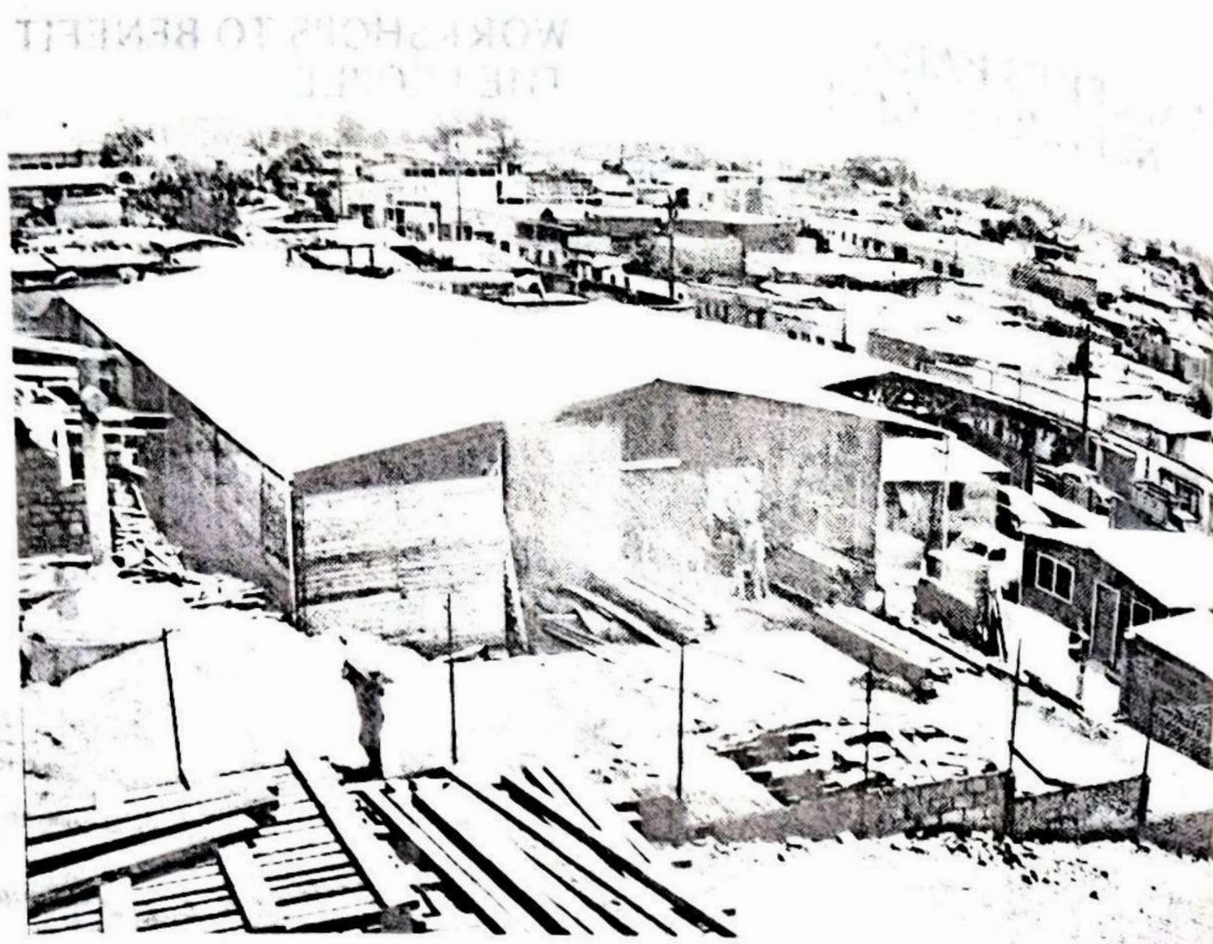
Vista parcial de las instalaciones de HODE, en los terrenos de la parroquia de San José Obrero.
