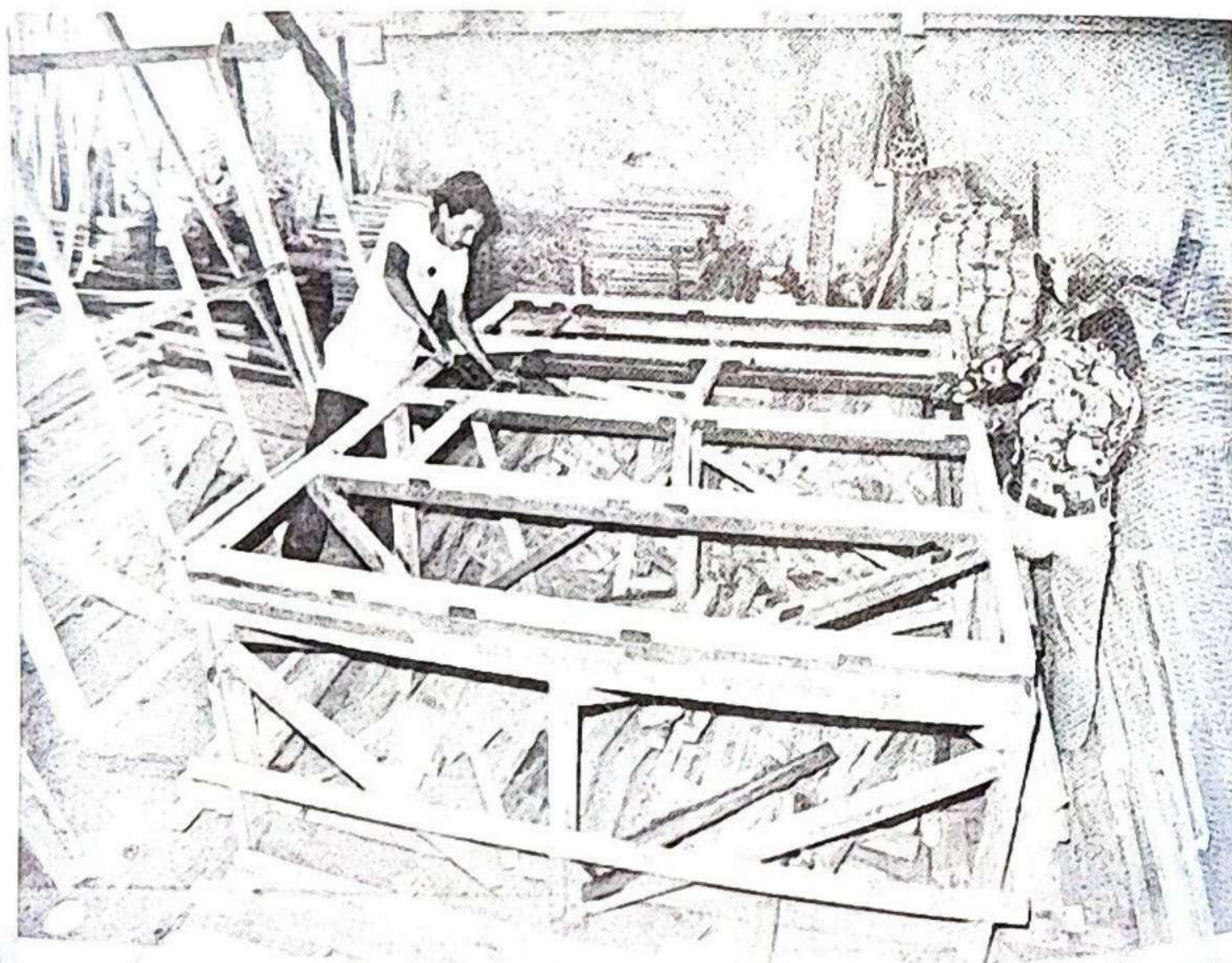
Las reglas precortadas son colocadas en los moldes o plantillas de metal para armar las estructuras de los paneles.
